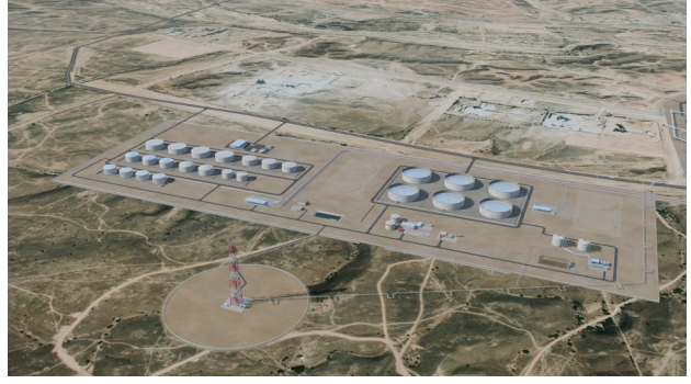
الشكل 10. منطقة الخزانات على أرض التخزين المستأجرة: ستة خزانات للنفط الخام سعة كل منها 116,000 م 3 ، وخزانات المنتجات والغاز المسال
