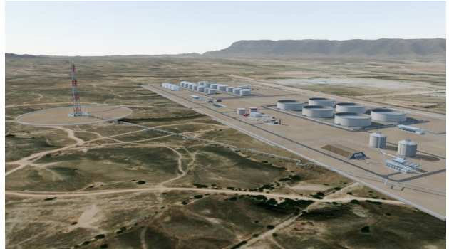
الشكل 12. خزانات الغاز المسال المبرّدة والمغطاة بالتراب والشعلة المرتفعة بارتفاع 150 م
