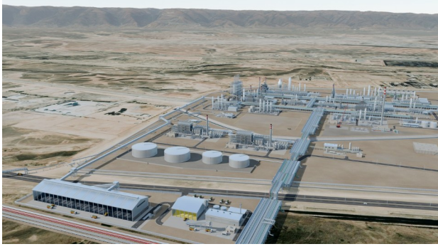
الشكل 11. وحدة التفحيم المؤجل ووحدتا الهيدروجين واستخلاص الكبريت
